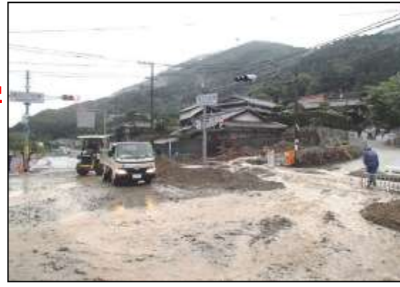
水路閉塞による国道通行止 平成26年8月(箕面市)
