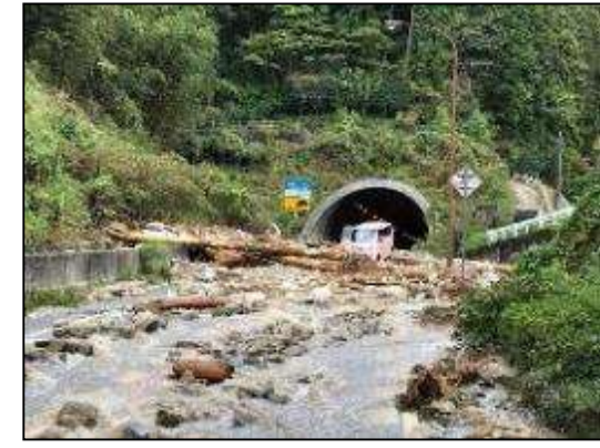
土石・流木流出による国道通行止 平成29年10月(千早赤阪村)
