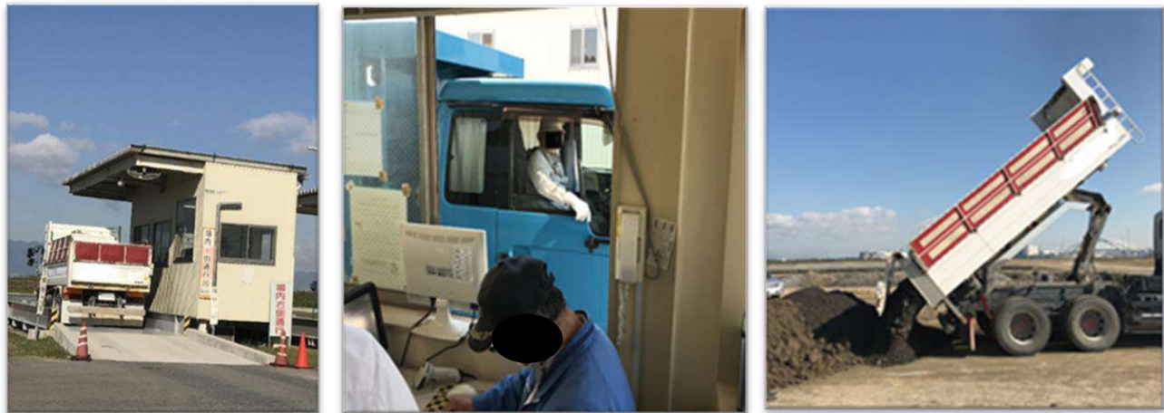
ブースにトラックが到着 搬入カード確認・計量伝票発行 建設発生土・軟弱土砂を降ろす
