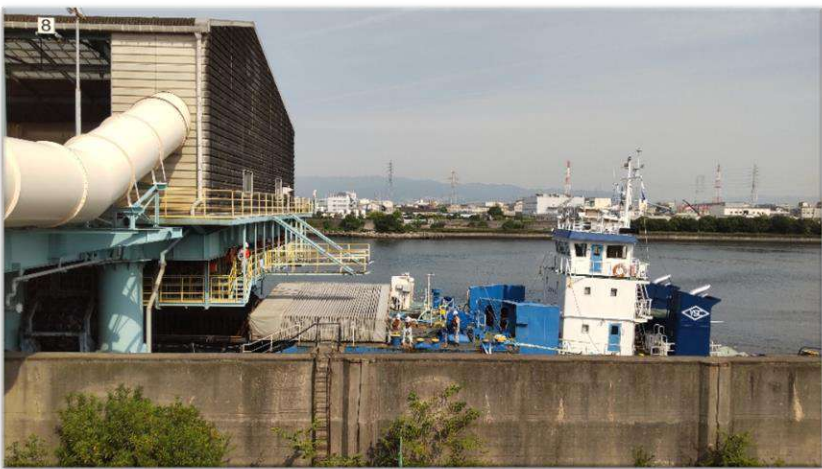
トラックから落ちてくる廃棄物を受入れているところ
