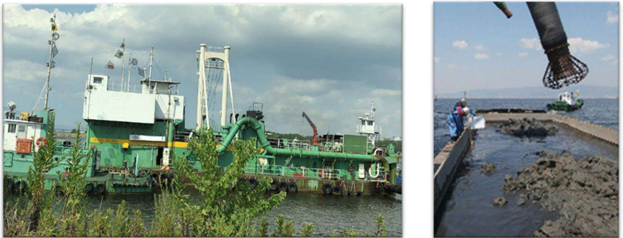
浚渫土砂を受入れる船 浚渫土砂
