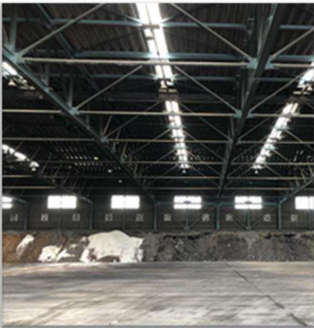
廃棄物の管理型ストックヤード
